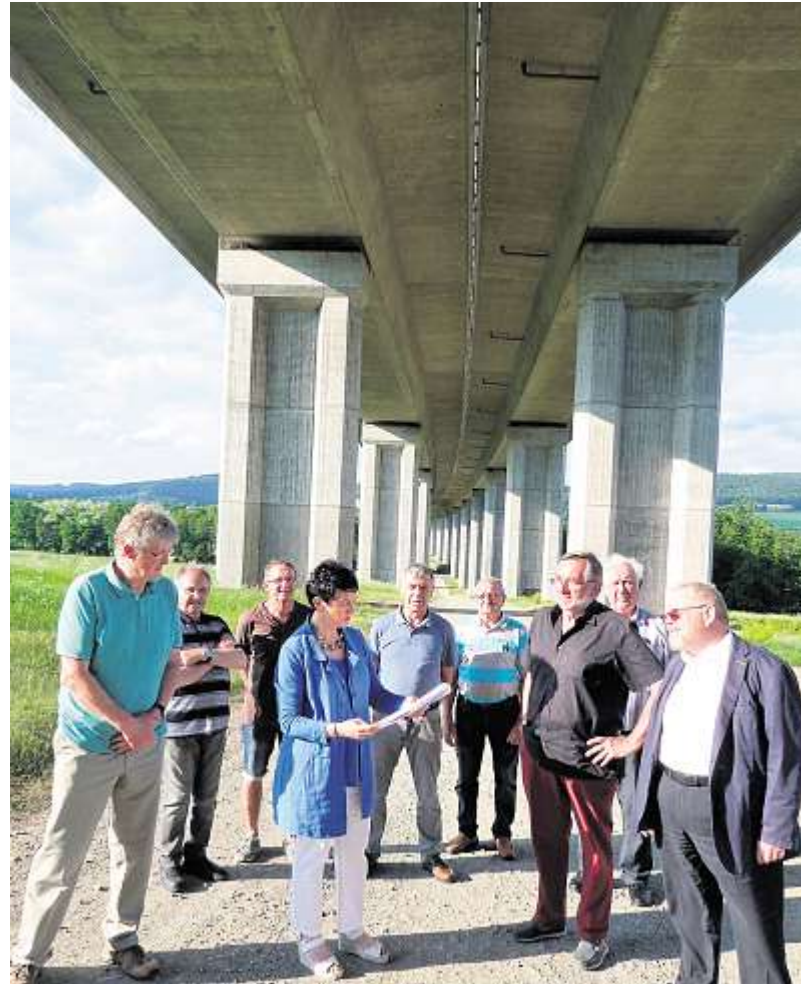
Direkt unterhalb der Lanzendorfer Talbrücke gab Landtagsvizepräsidentin Inge Aures (Mitte) den Sanierungsbeginn für das Jahr 2019 bekannt. Rechts ihr Fraktionskollege im Landtag, Klaus Adelt. Foto: Klaus-Peter Wulf
